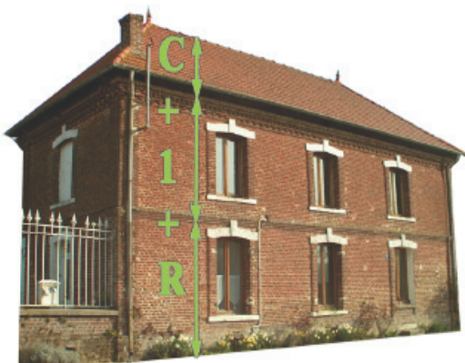
Hauteur d'une maison du village
