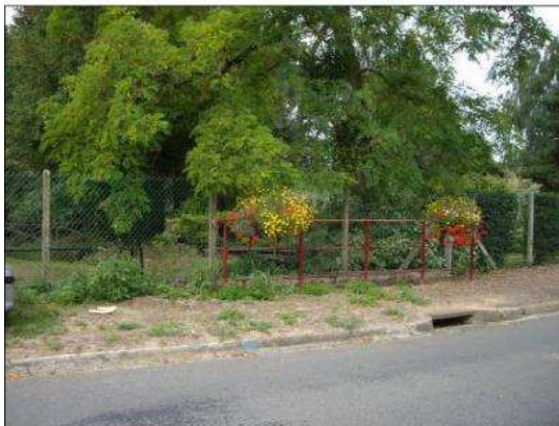
Bouche de récupération des eaux œ, au niveau du Ru des étangs
