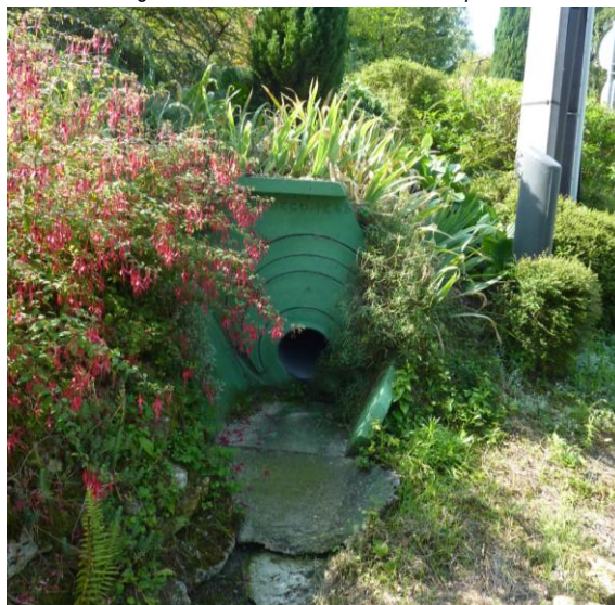
Figure 15. Exutoire de la rue des coquets
