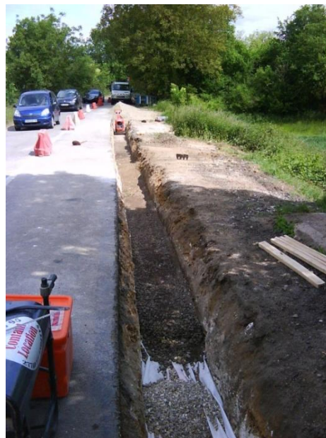
Figure 12. Photographie représentant une tranchée de pose de canalisation
