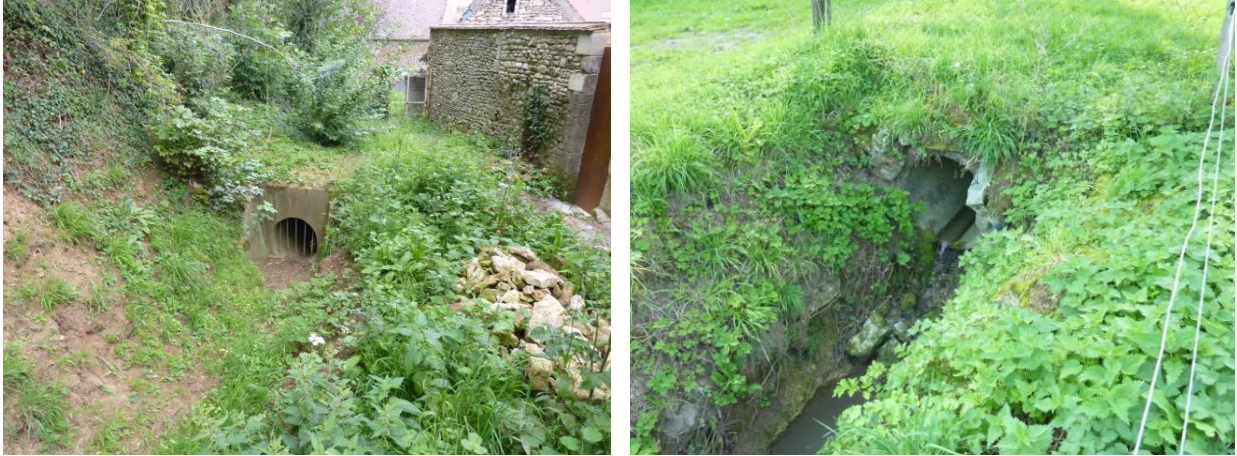
Figure 13. Entrée des eaux de ruissellement du fossé du chemin du Tour de Ville et son l'exutoire
