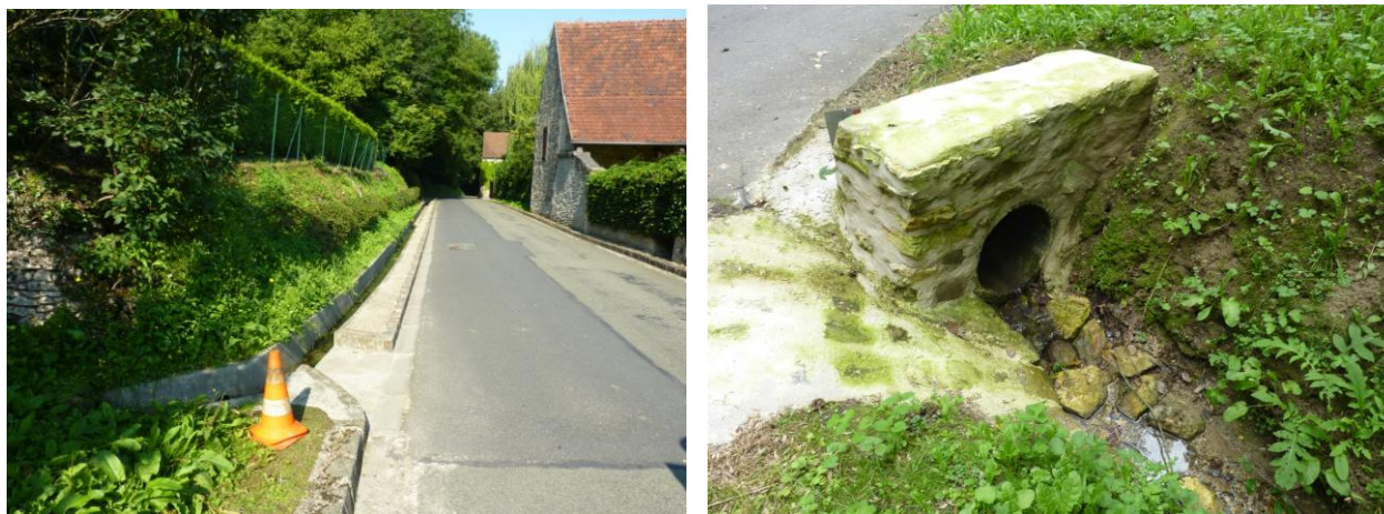
Figure 12. Caniveau collectant une partie des eaux de pluie de la rue Saint-Denis et son exutoire
