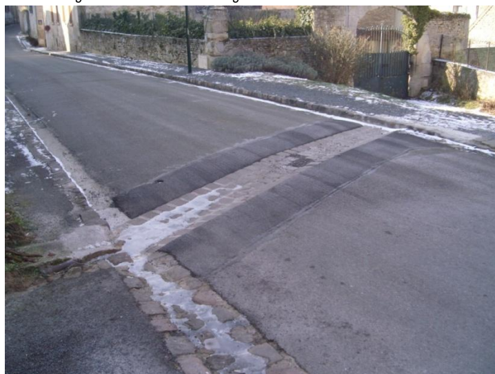
Figure 21. Caniveau aménagé au niveau de la rue Saint-Denis
