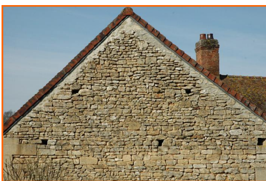
La pierre calcaire est le matériau traditionnel
