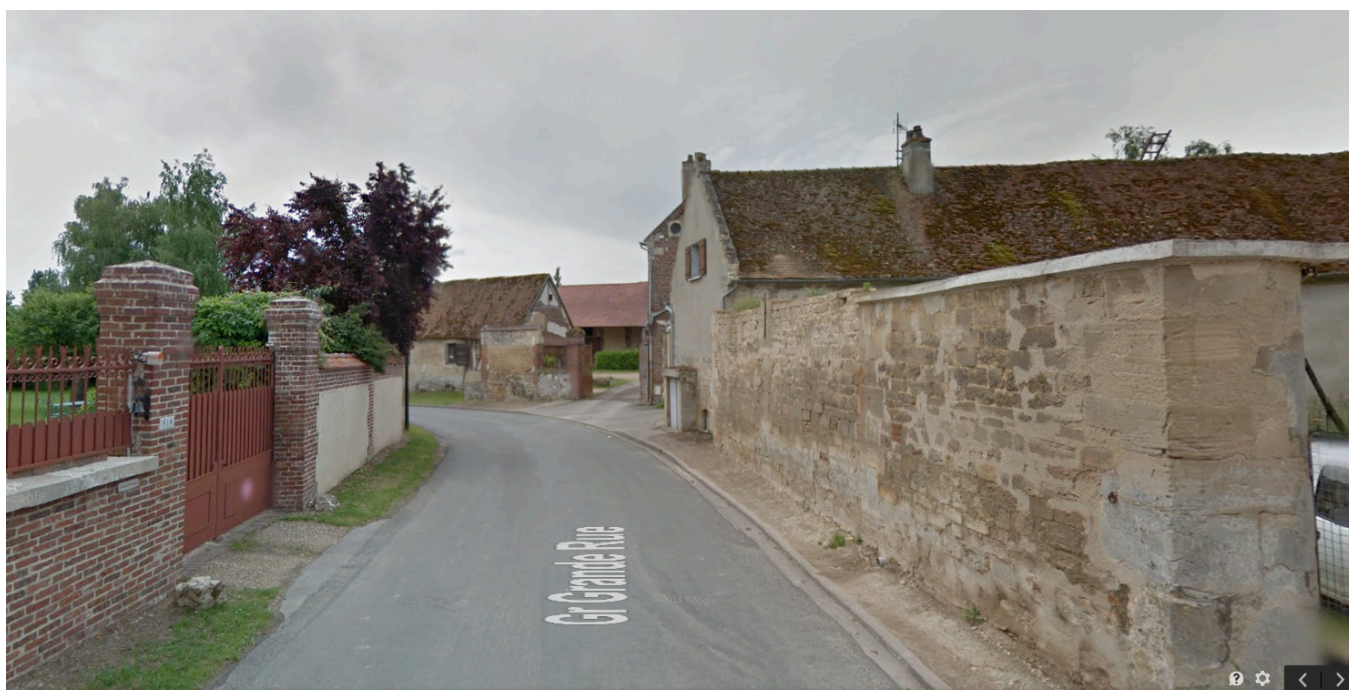
Murs en briques rouges et murs en pierres (Grande Rue)
