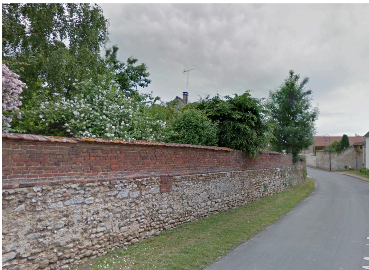
Murs en pierres et briques (Grande rue)
