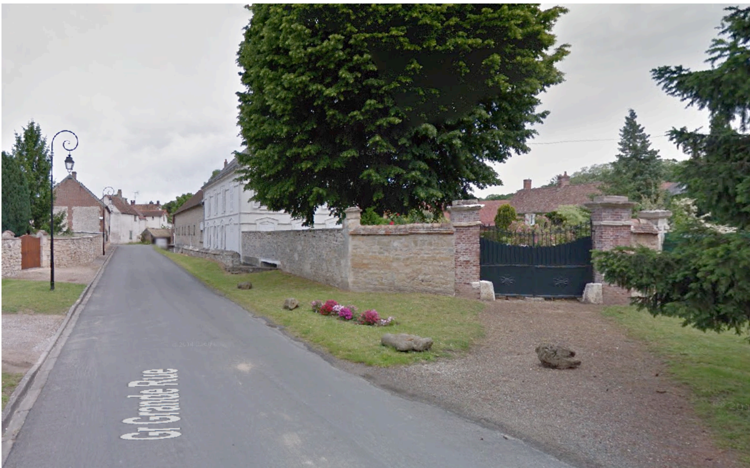
Murs en pierres et piliers en briques rouges (Grande Rue)
