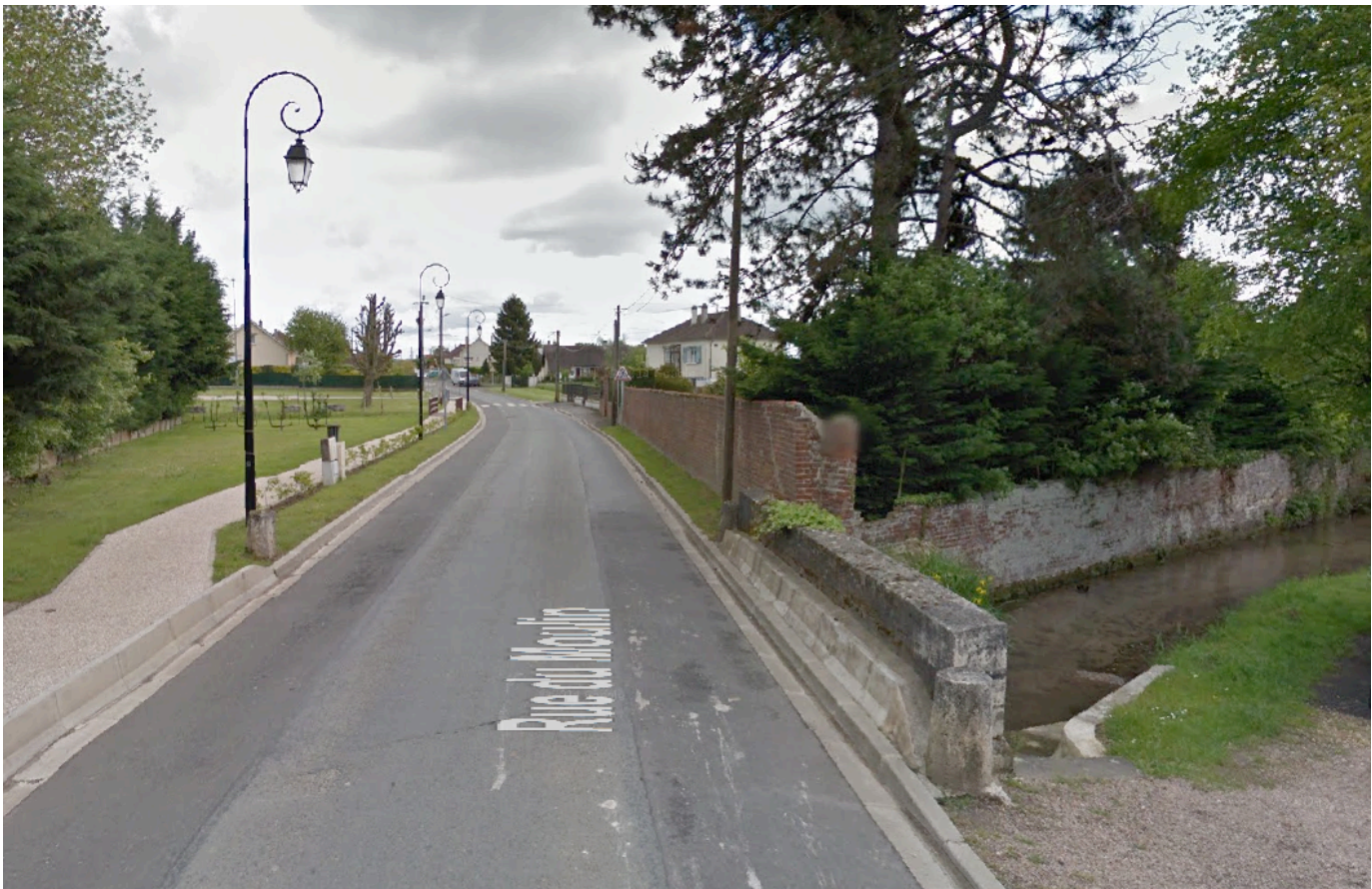
Mur en brique rouge (rue du Moulin)
