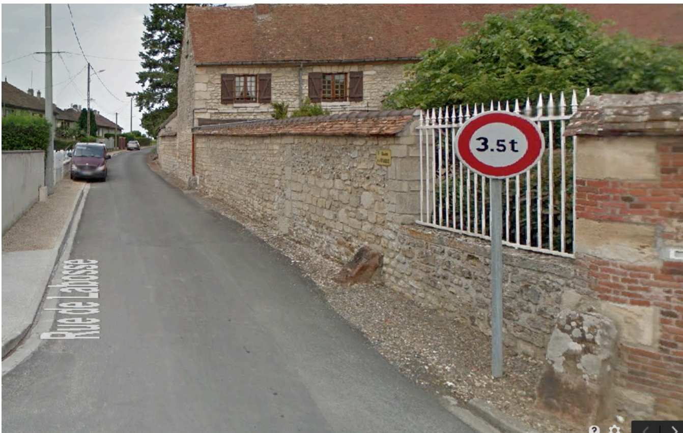
Murs en pierres (Rue de la Beauce)
