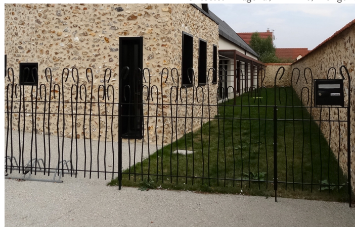
Ferronneries contemporaines formant une clôture
