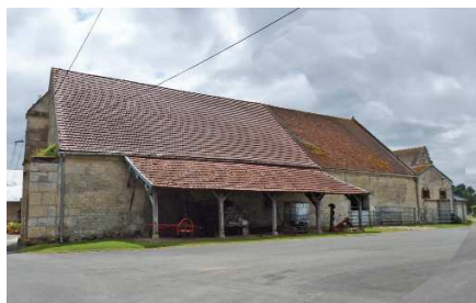
Ferme Neuville : Grange en pierre avec contreforts
