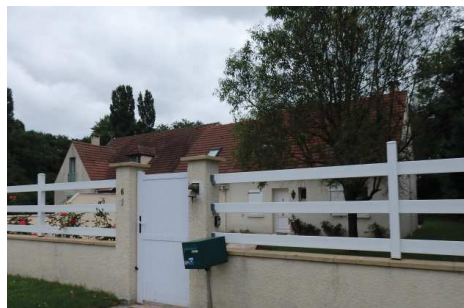
Secteur pavillonnaire Clos de la Bergerie.
