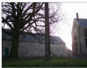
Bâtiments de la ferme en entrée de Feigneux, et placette accueillant un arbre remarquable
