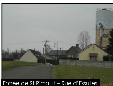
Entrée de St Rimault – Rue d'Essuiles
