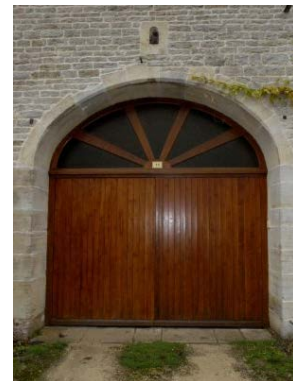
Porte pleine et imposte vitrée - Arc cintré
