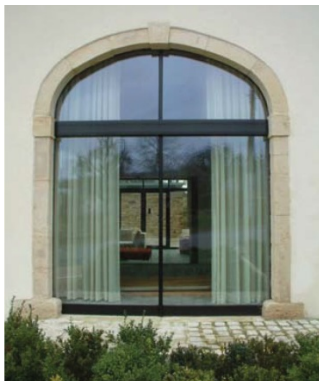
Porte vitrée - Arc cintré
