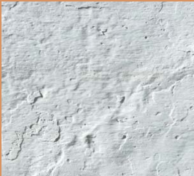
Badigeon au lait de chaux
