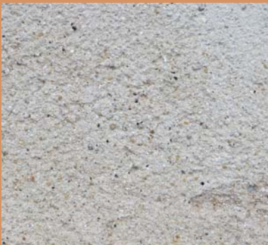
Enduit couvrant à texture grossière
