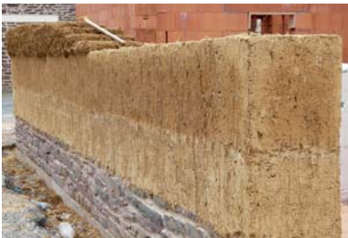
Mur en bauge en cours de construction
