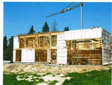
Chantier d'une maison à ossature bois
