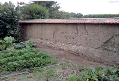
Mur de clôture en pisé
