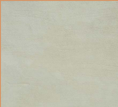
Enduit couvrant étiré à la taloche
