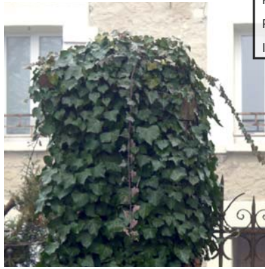
Dévégétaliser les piles et murets
