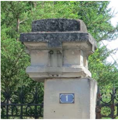
Recaler les pierres de chapiteau
