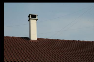
Les tuiles mécaniques
