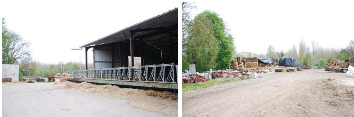
Figure 12 : Terrain occupé par un bâtiment agricole et du stockage de paille
