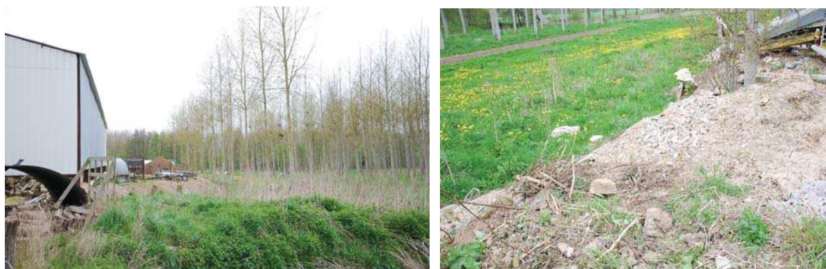
Figure 13 : Terrain remblayé, n'étant plus soumis au risque d'inondation
