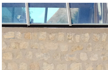
Moellons et vitrage
