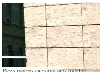
Blocs pierres calcaires sans mortier
