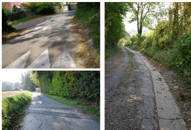
Figure 34: Aménagements pour canaliser les eaux de ruissellement
