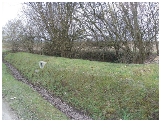
Figure n°11 : Bassin de rétention des eaux à l'entrée de la carrière du chemin de Vez (Source : AlpGéorisques (gauche) ; Guy Launay (droite))
