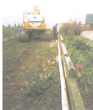
Travaux de pose du drain (1986)
