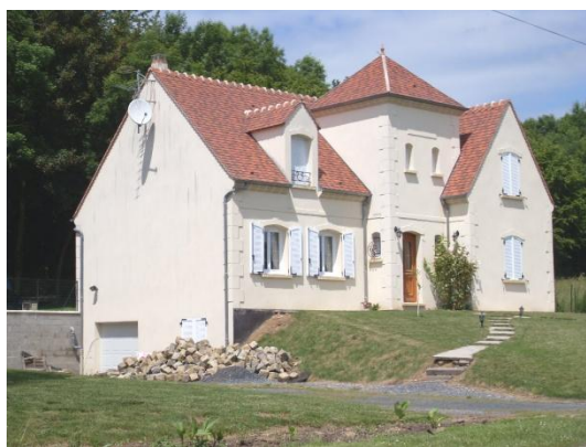
Construction pavillonnaire sur sous sol surélevé avec tour carrée
