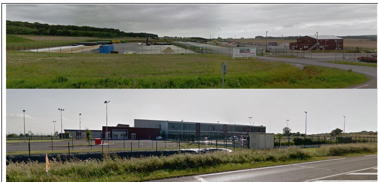
Figure 26 : Installations liées au stockage de gaz
