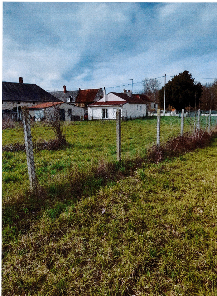
Vues sur la propriété bâtie depuis la parcelle AD n°42, le grillage marque la limite entre la parcelle AD n°40 et la parcelle AD n°42.
