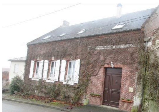
Rue de l'église Toitures en ardoises / 2 pans Ouvertures type châssis de toit Ligne de faîtage parallèle à l'axe de la rue
