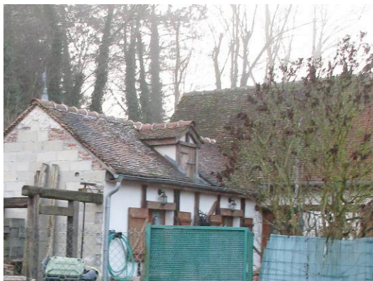
Rue d'en bas Lucarne à 2 pans dite jacobine ou en bâtière
