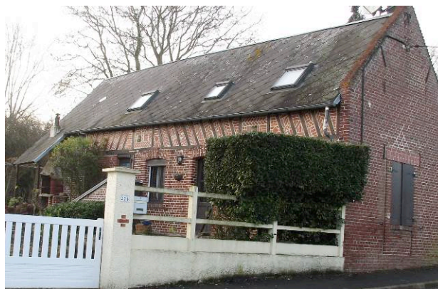
Rue d'en bas Construction en briques avec pans de bois Ancres sur pignons
