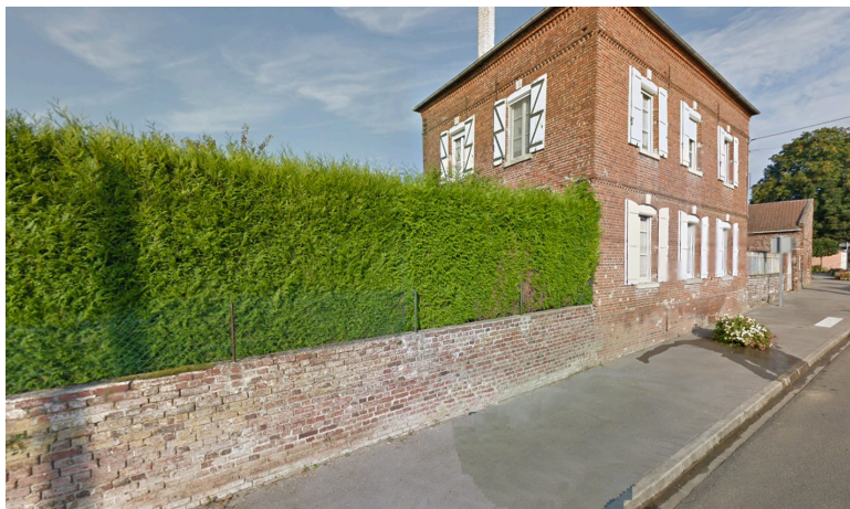
Muret en briques rouges de pays, rue de la Mare des Saules.
