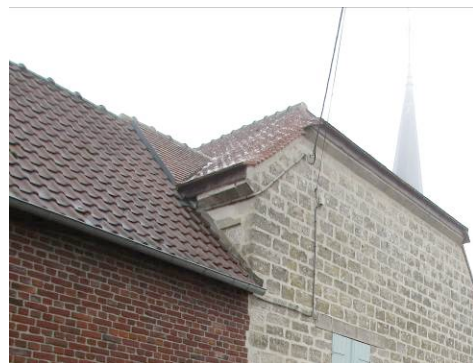
Rue de l'église Toiture en tuiles mécaniques
