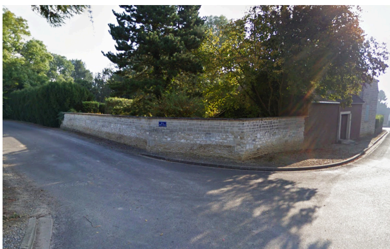
Mur en pierres, rue du tour de Ville.
