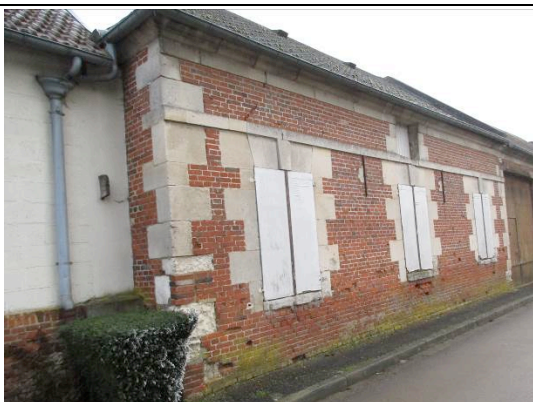
Grande rue Construction en briques / Chaînage d'angles, encadrement et corniches en pierres
