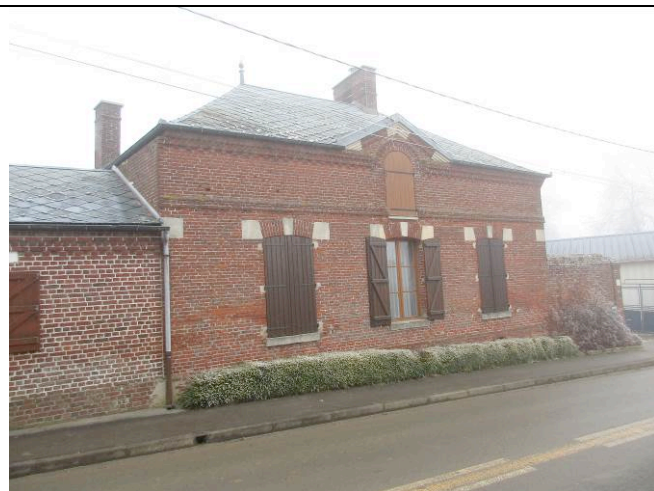
Rue de la mare des saules Toitures en ardoises à 4 pans Cheminées rectangulaires en briques rouges Epi en zinc
