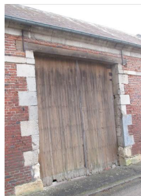
Grande rue Porche carré avec encadrement en pierre et linteau en bois
