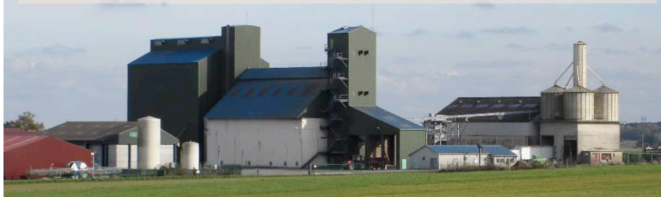
Silo agricole en limite de territoire avec Erquinvillers et à proximité des bâtiments de la ferme d'Erquinvillers située sur Erquinvillers
