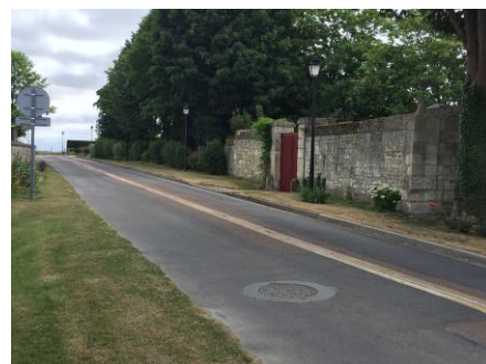
⑤ accès et murs de clôture existants
