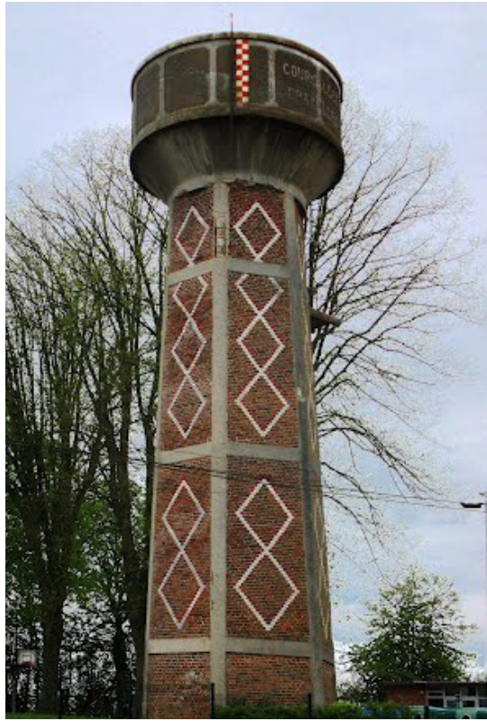
Le château d'eau
