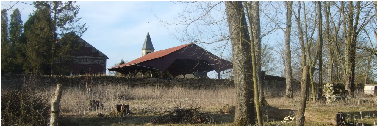
Hangar agricole en arrière de parcelle, en frange de village.
