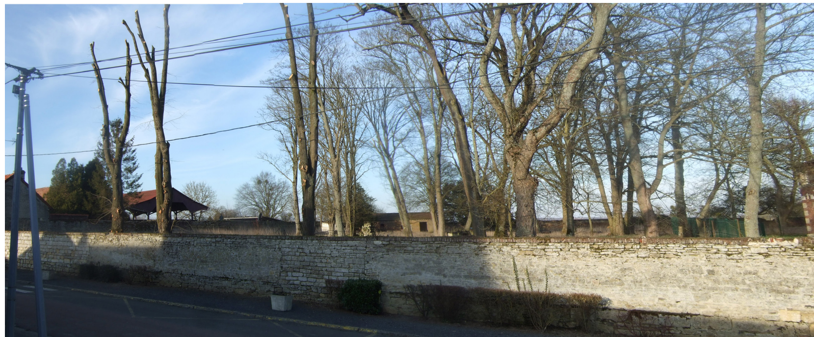
Un mur en pierres participant de la continuité de la trame bâtie.
