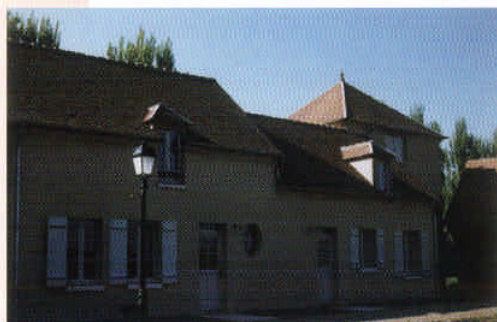
Extension de maison (78) F. Millet, Architecte
