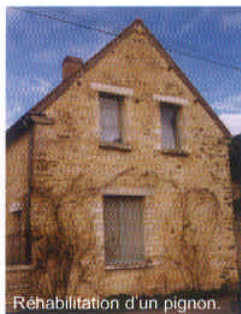
Réhabilitation d'un pignon.
