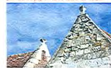
portails de pignon avec fleurs du maçon
