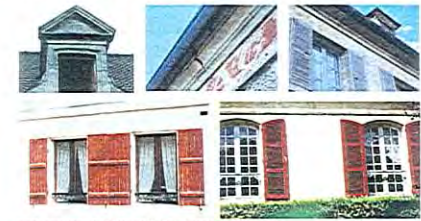
modénatures en pierre de taille : bandeau, corniche
