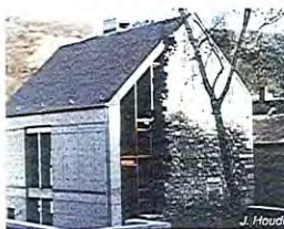
ravalement de mur de brique, joints à la chaux avec un appareillage panerisse/bou-tisse, occultation par un store intégré
