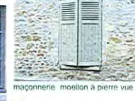
mur appareillé en pierre, harpes en pierre de taille et remplissage en moellon lié au mortier de chaux
