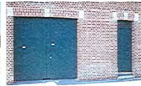
ravalement de mur de brique, joints à la chaux avec un appareillage panerisse/bou-tisse, occultation par un store intégré
