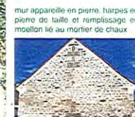
mur appareillé en pierre, harpes en pierre de taille et remplissage en moellon lié au mortier de chaux
