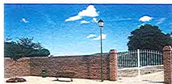
mur de brique rouge avec portail en ferronnerie
