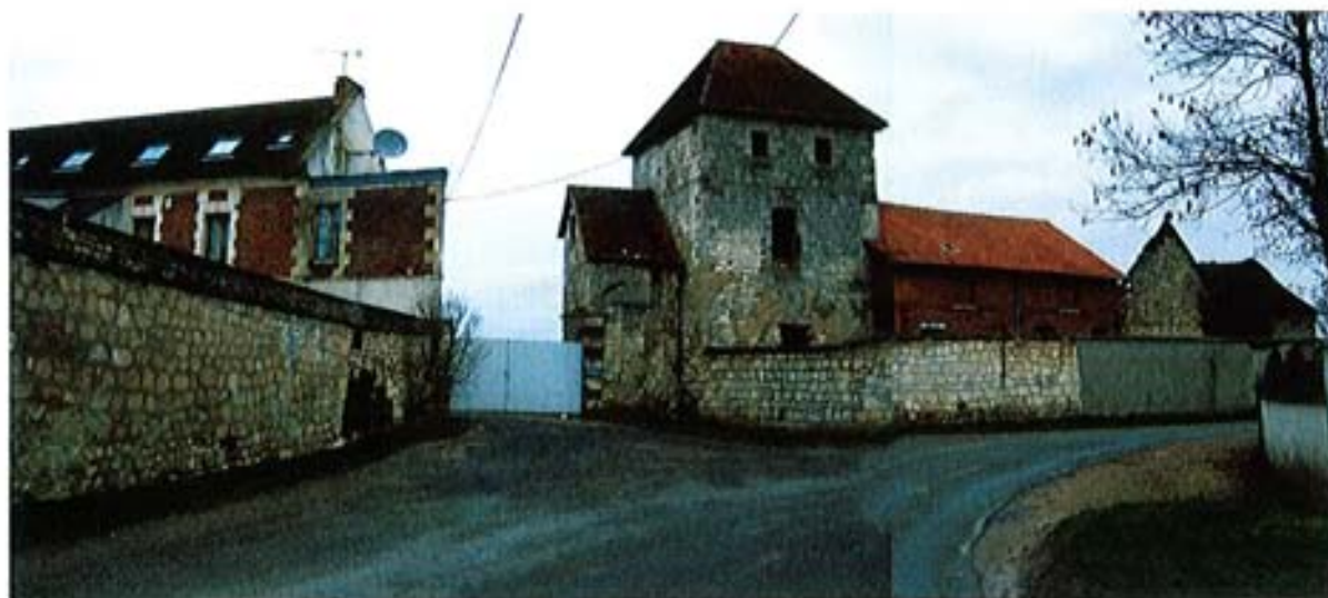
Depuis la rue de Lombarde, vue sur les bâtiments existants de l'ancienne ferme présentant un intérêt patrimonial.
