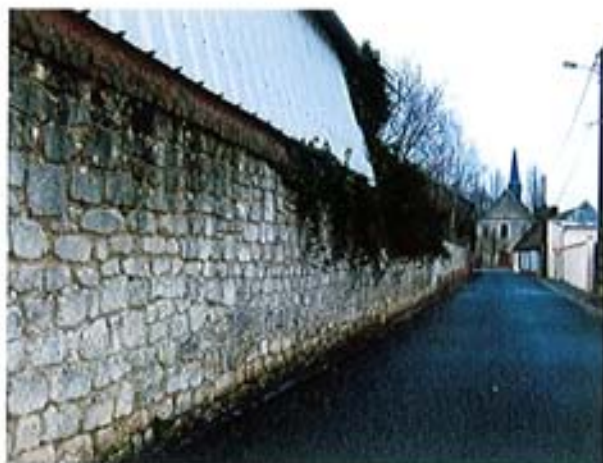
Mur en pierres délimitant l'ancien corps de ferme rue du 8 mai 1945
