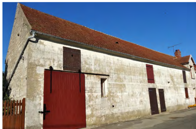
Portes coulissantes pour un usage pratique (Liancourt-St-Pierre)
