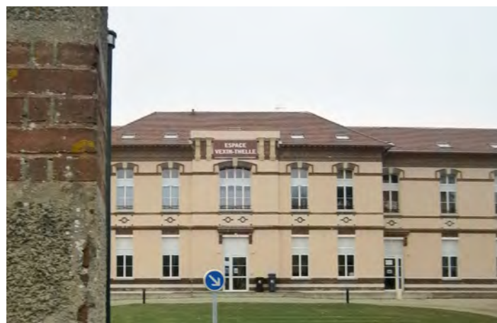
Reconversion d'un équipement public
