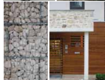
Matériaux : résilles métalliques pour plantes grimpantes, mur en gabion (caisson en treillage métal rempli de caillasse), mur en moellon enduit à pierre vue et clins de bois associés aux fenêtres cadrées
