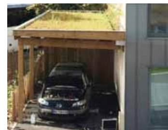
Auvent pour voiture surmonté d'une toiture végétalisée
