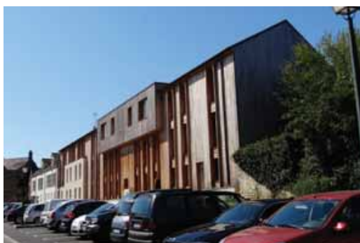
Immeuble de logements en bois construit en front de rue en continuité du bâti ancien, Magny-en-Vexin
