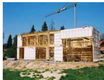
Chantier d'une maison à ossature bois
