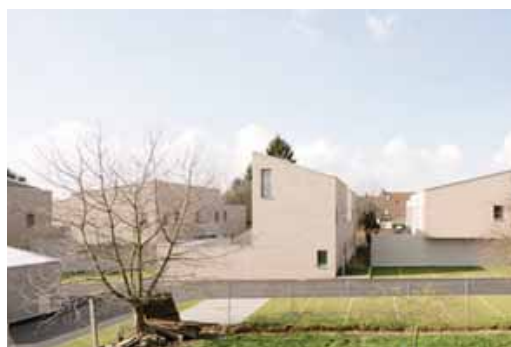
Construction de logements avec une écriture contemporaine et collective dessinant une succession de jardins privatifs et de terrasses, archi. A. Foucheur
