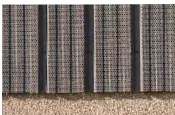
Enduit et bac acier
