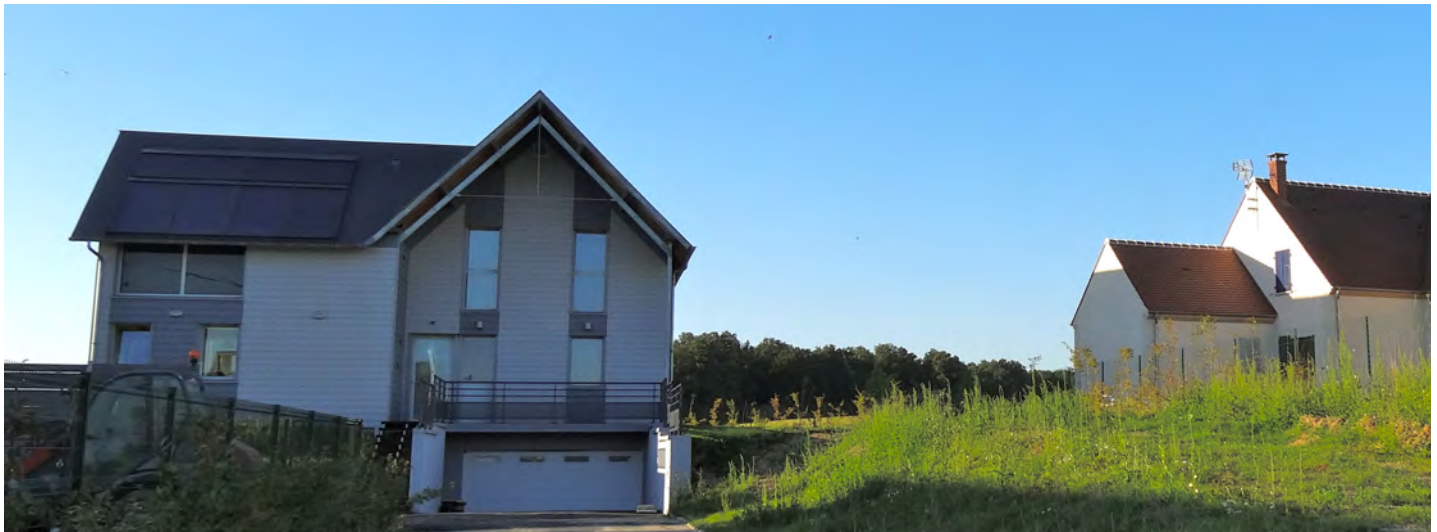
Maison contemporaine reprenant le volume et la forme d'une construction traditionnelle
