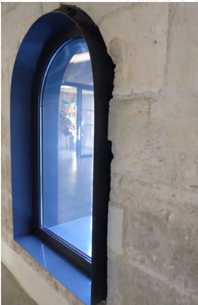
Réhabilitation d'une baie d'un mur de pierre (Louviers)
