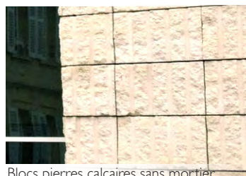
Blocs pierres calcaires sans mortier
