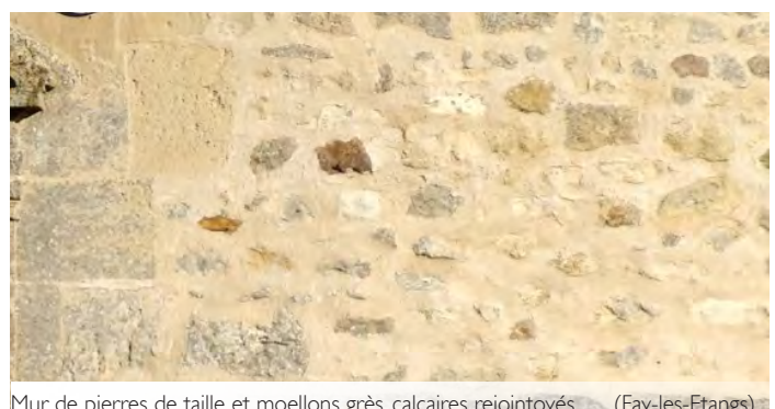
Mur de pierres de taille et moellons grès, calcaires rejointoyés (Fay-les-Etangs)
