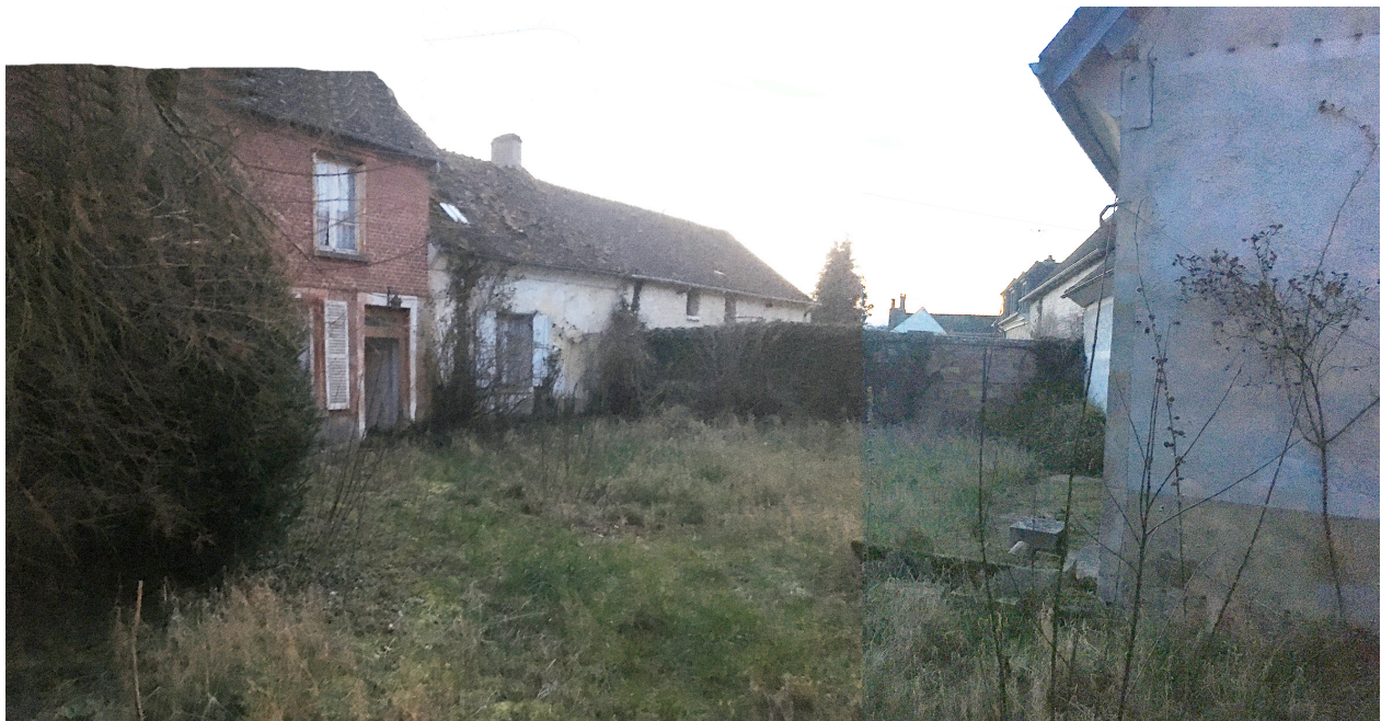
Vue sur la propriété actuellement non occupée à l'angle de la rue Saint Amand et de la rue de Gisors.
