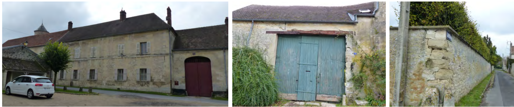
Façade du corps de ferme de Balagny, porte chartière d'une maison rurale à Balagny et mur traditionnel en pierre
