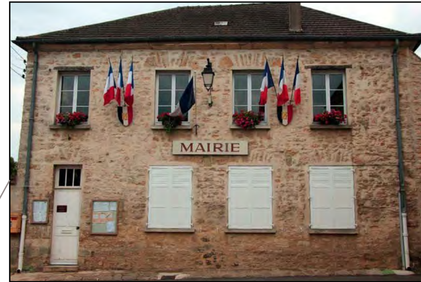
Mairie de Chamant dans le centre-ancien
