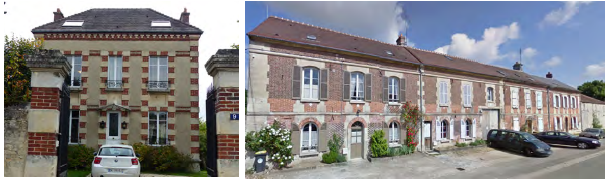
Les maisons de village : maisons bourgeoises généralement en R+1+comble et dont les façades sont ornées de corniches, de chaînes d'angle et d'encadrement de baie
