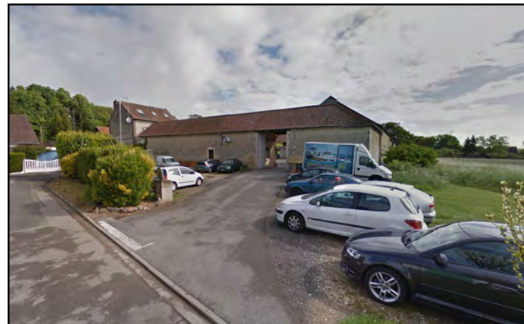
Accès problématique entre l'impasse Bertrand de Valon et le secteur commercial, accessible depuis la route de Compiègne
