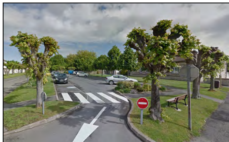
Parc de stationnement aménagé à proximité de l'école, à l'entrée du centre-ancien
