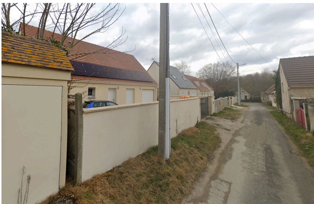
4 maisons d'habitation réalisées rue du Cul de Sac dans l'emprise du secteur soumis aux OAP n°3.
