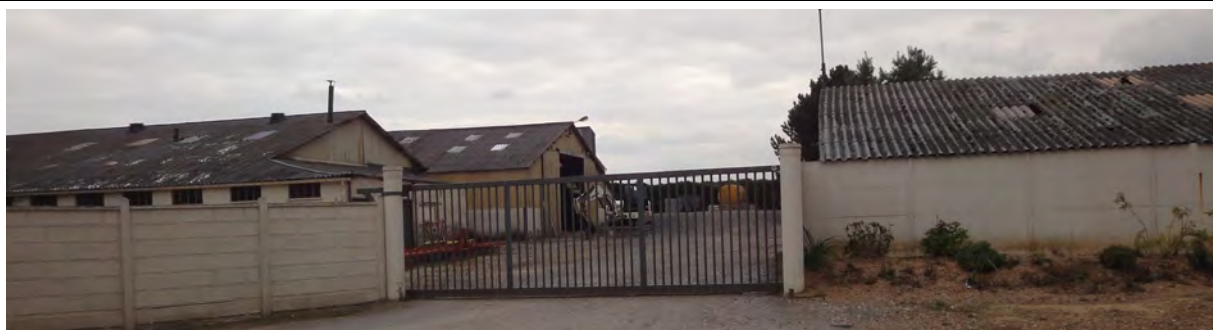
Rue de thieux Exploitation H
