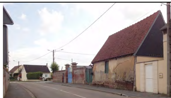
Rue de Saint Just Grange en alignement sur rue prolongé par un mur de clôture en briques avec grilles caractéristiques (construction en retrait)
