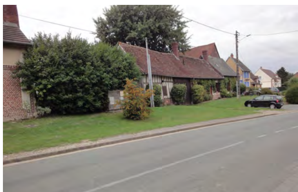
Alignements de constructions anciennes rue de Beauvais
