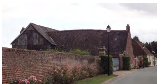
Rue de l'église Grange avec pignon sur rue Faîtage perpendiculaire à la voie Mur de clôture en briques
