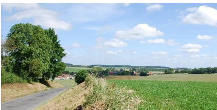
Talus végétalisé (présence d'arbres) protégé le long de la rue Montagne, en limite communale avec Catigny
