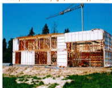
Chantier d'une maison à ossature bois
