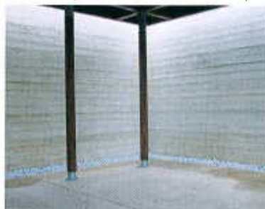
Préau aux Clayes-sous-Bois, archi. Anne Delaunay
