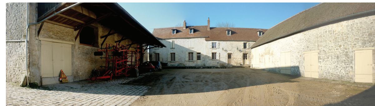
Siège agricole situé au nord de la place Viat-Bierry (bâti de valeur patrimoniale).
