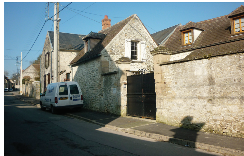
Construction ancienne avec ouverture sur les façades et pignons.
