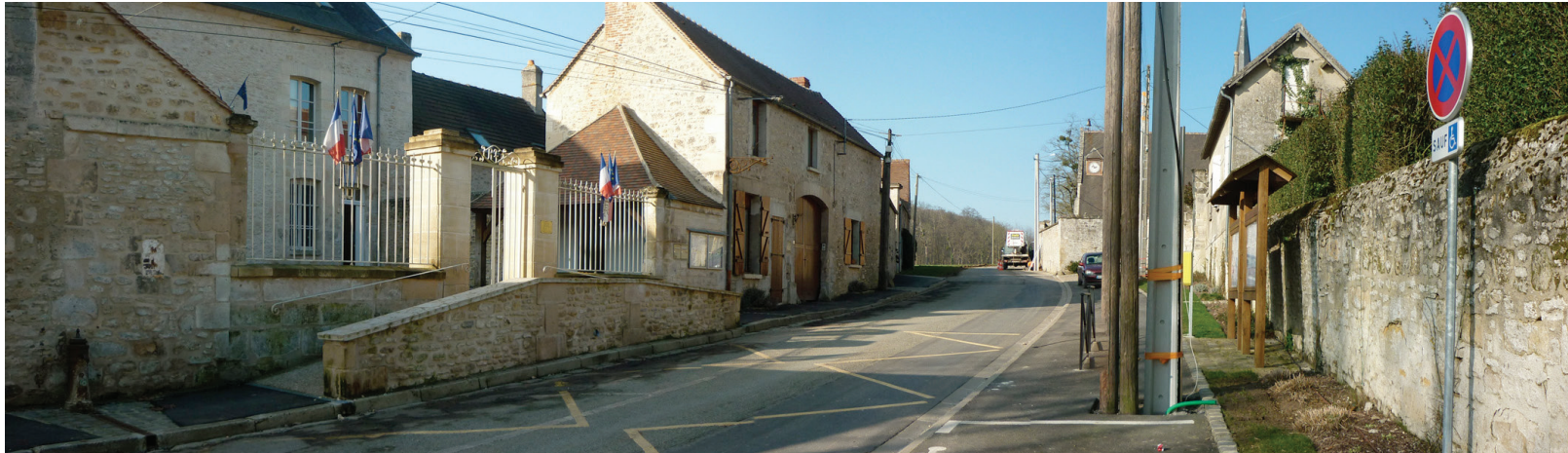
Des rues essentiellement minérales dues à une implantation du bâti à l'alignement et à de nombreux murs en pierres.
