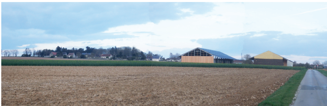
Vue sur les nouveaux bâtiments agricoles en cours de réalisation, en entrée ouest du village.
