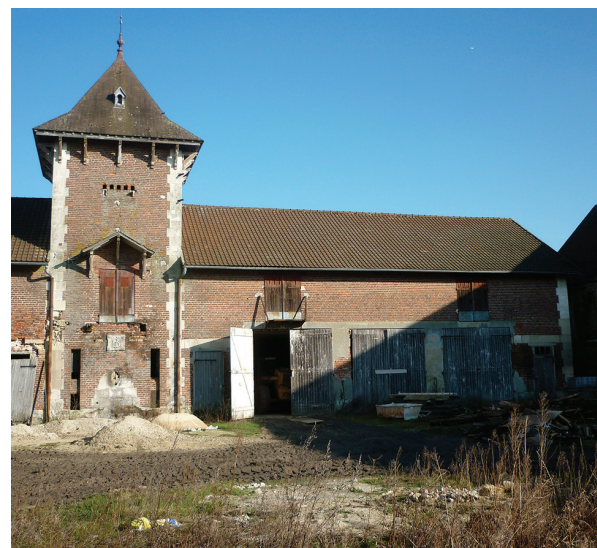
Construction en briques rouges
