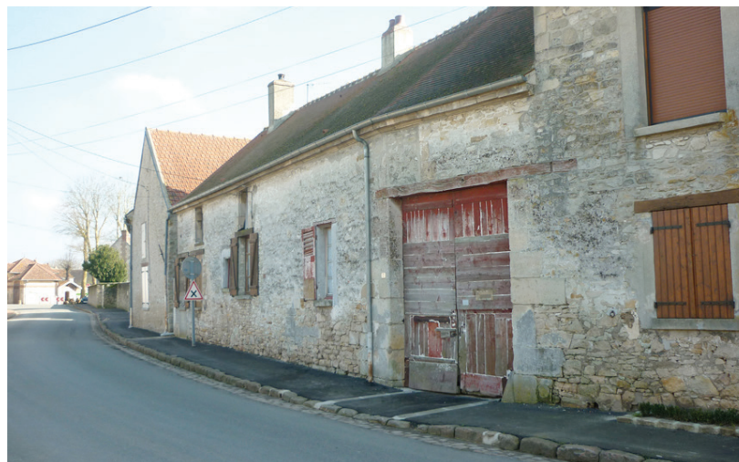
Construction ancienne accessible depuis un porche.
