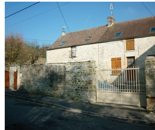
Façade en moellon et enduit ton pierre
