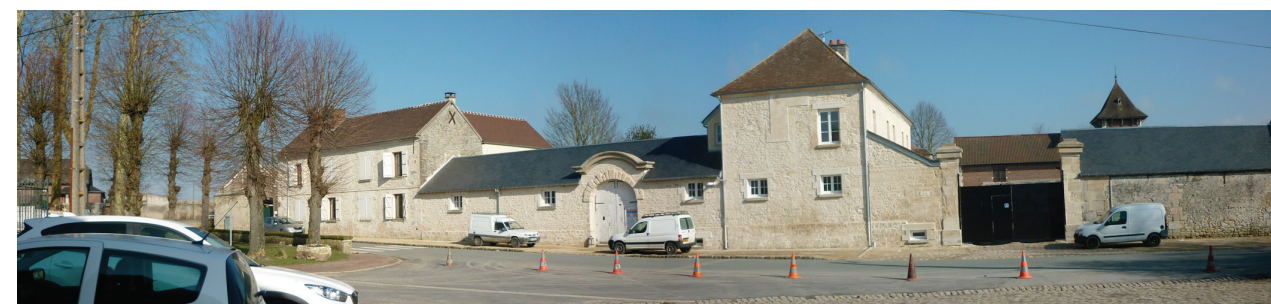
L'ancien corps de ferme situé en plein cœur du bourg, (est de la place Viat-Bierry) soulève de multiples enjeux dans ses perspectives de développement.
