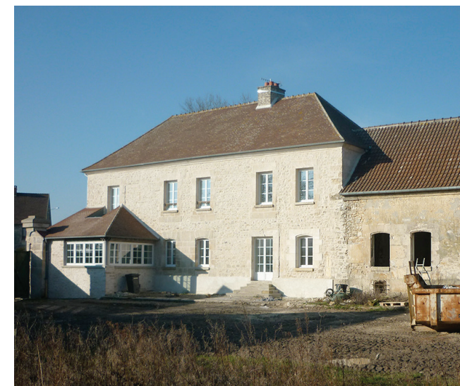
Réhabilitation conservant les caractéristiques vernaculaires du bâti
