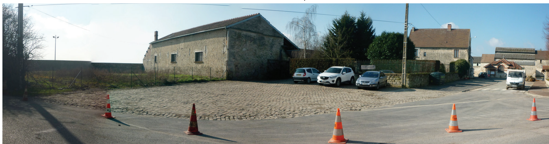
Modification de la place Viat-Bierry qui redonne de la place aux piétons et au stationnement des véhicules.
