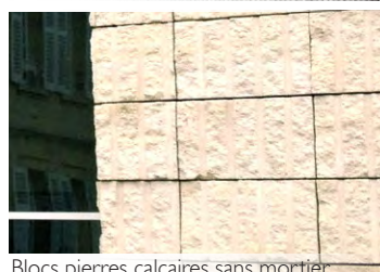
Blocs pierres calcaires sans mortier
