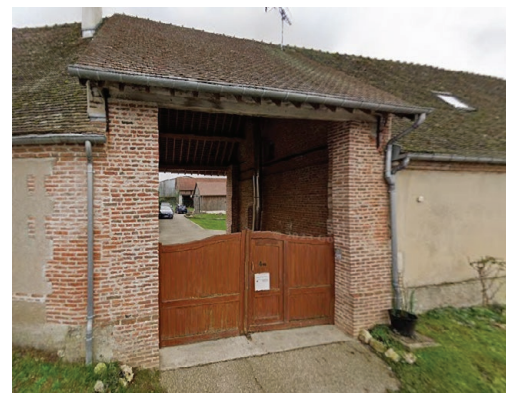
Porche rue de la Chapelle.
