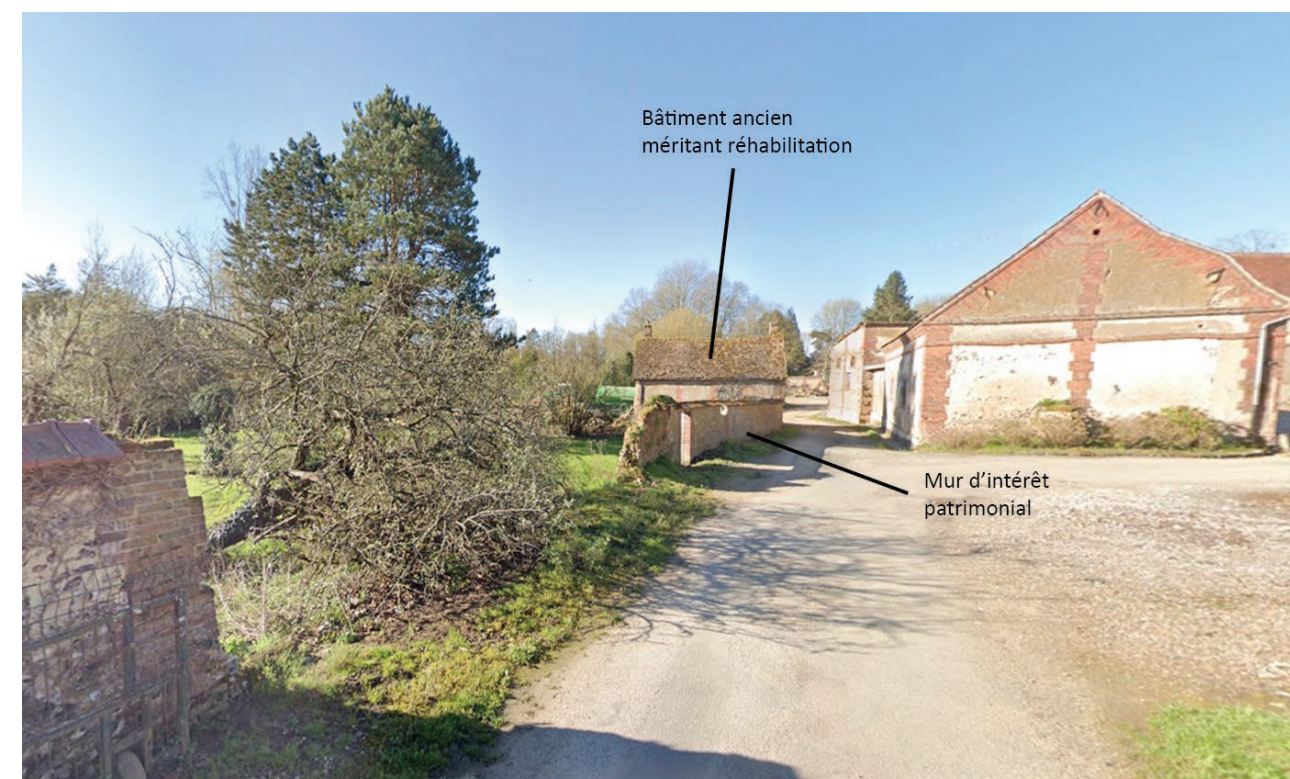
Impasse de la Place à Boutencourt, côté gauche, emprise disponible pour recevoir de nouvelles constructions et mur ancien d'intérêt patrimonial ; au fond, bâti ancien qui mériterait une réhabilitation.
