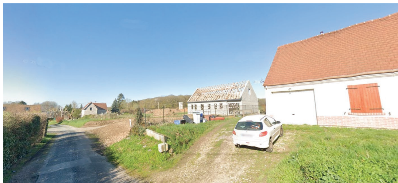
Entre la rue du Calvaire et la rue de la Forge, habitations individuelles en cours de construction.
