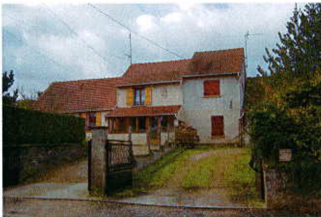
Construction en retrait de la rue, façade enduite, clôture évidée (haie sur muret en moellon).
