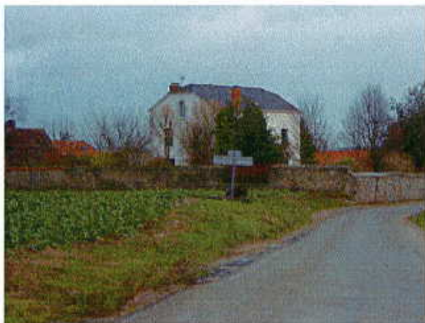
Toiture en ardoise sur pavillon du XIXeme
