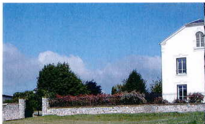
Murs et muret avec grille à préserver.
