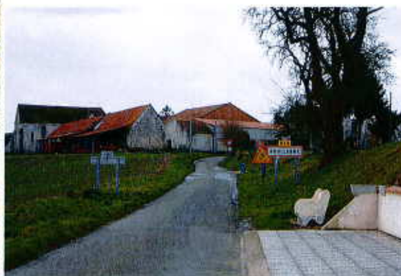
Bâtiment repère du corps de ferme.
