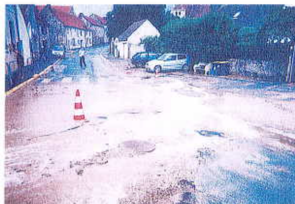
Evacuation de l'eau par avaloir situé rue des Fontaines
