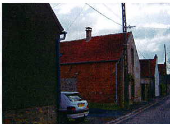
Alignement de pignons enduits rue des Fontaines
