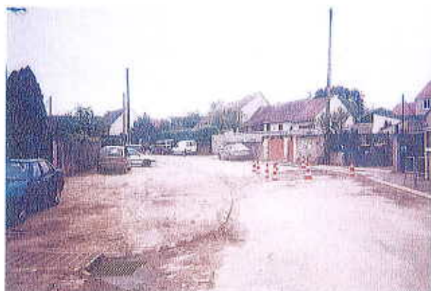
Vue sur l'avaloir rue des Fontaines
