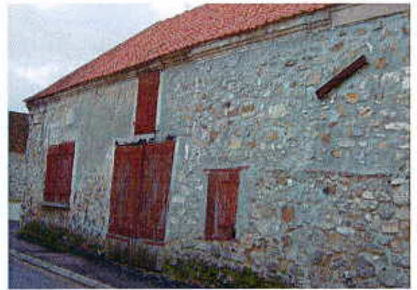
Dépendance de bâtiments agricoles en moellons apparents
