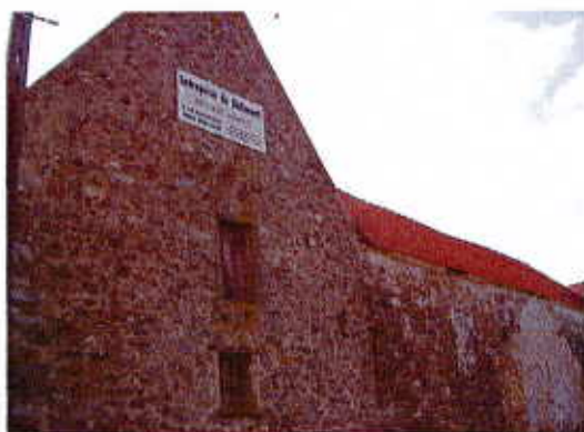
Entreprise de bâtiment
