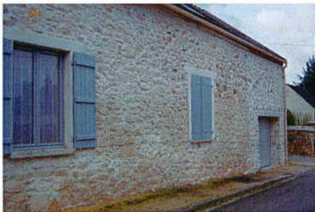
Façade restaurée (moellons apparents) et menuiseries bois
