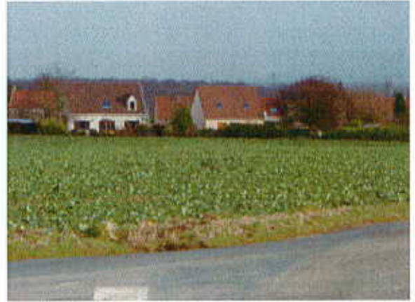
Pavillons insérés dans le bâti traditionnel à l'ouest du village.
