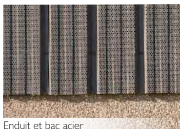
Enduit et bac acier
