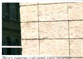
Blocs pierres calcaires sans mortier
