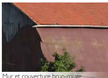
Mur et couverture brun-rouge
