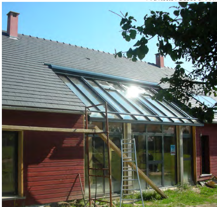
Création d'une verrière dans un volume traditionnel
