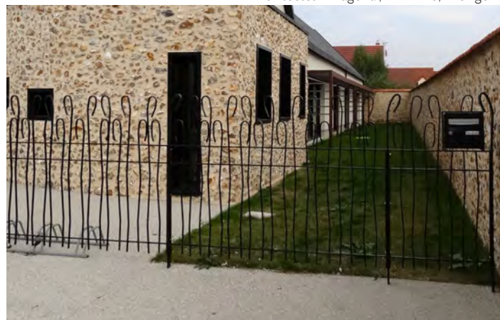
Ferronneries contemporaines formant une clôture
