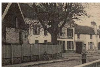
Une barrière en bois dans le village de Barbery au début du XXe siècle
