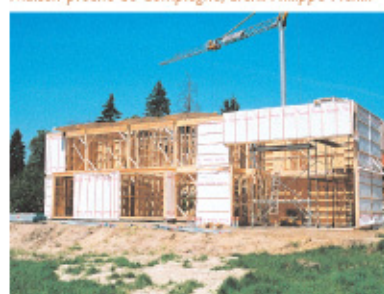
Chantier d'une maison à ossature bois
