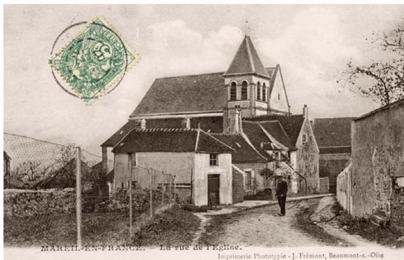
Mareil-en-France, le grillage remplace les haies et les clôtures en bois vers 1900
