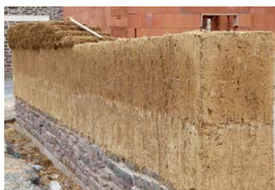
Mur en bauge en cours de construction
