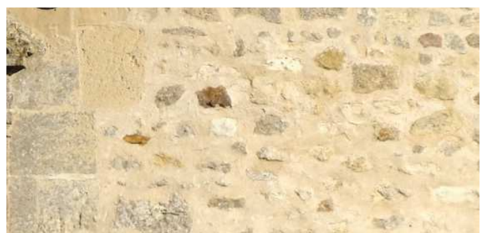
Mur de pierres de taille et moellons grès, calcaires rejointoyés (Fay-les-Etangs)
