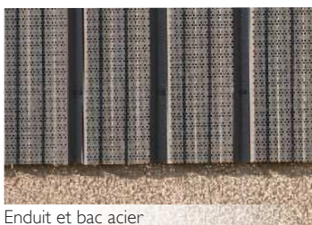
Enduit et bac acier
