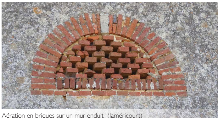
Aération en briques sur un mur enduit (Jaméricourt)
