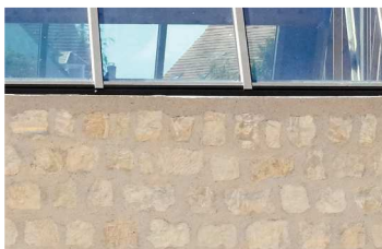
Moellons et vitrage
