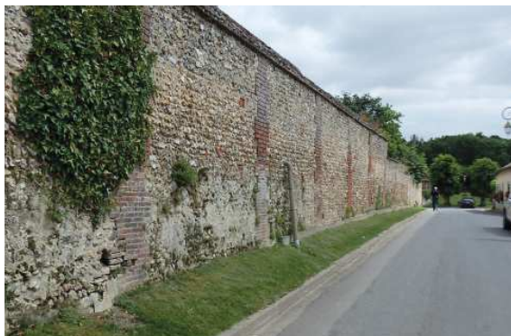
Rue de la Mairie : mur et bâti à l'alignement, trottoir enherbé peu accessible, sans stationnement
