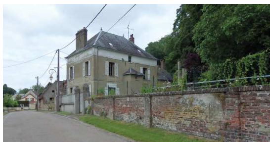
Construction R+1+ combles en léger retrait de rue de forme carrée en enduit et ardoises
