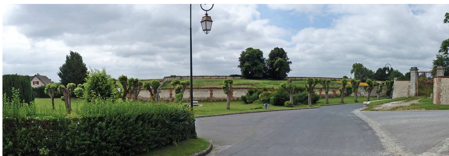
Emprise (en orange) de l'ancien potager du château présentant un potentiel aménageable (vue éloignée).
