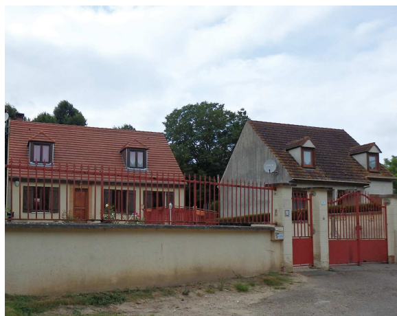
Constructions pavillonnaires des années 1990 en retrait de voie chemin de la Cavée.
