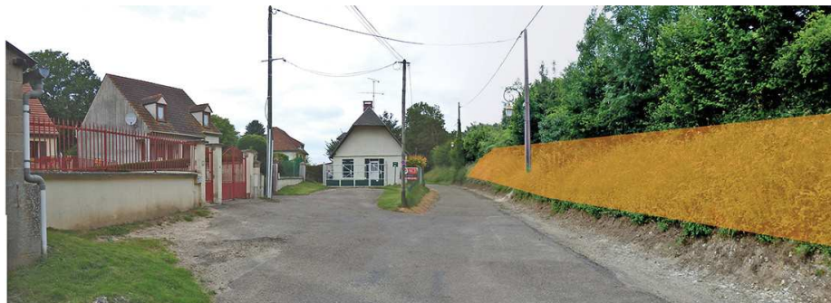
Emprise (en orange) rue de la Cavée présentant un potentiel aménageable venant en surplomb de la voie.
