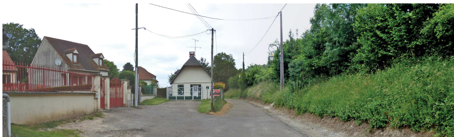
Limite nord de l'urbanisation composée à l'ouest de constructions de type pavillonnaire et d'un talus planté à l'est (Chemin de la Cavée)
