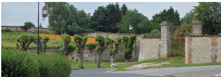
Emprise (en orange) de l'ancien potager du château présentant un potentiel aménageable (vue rapprochée).
