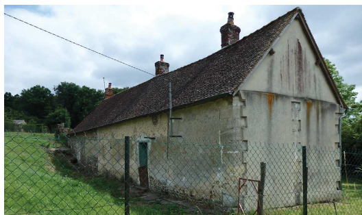
Construction vacante ancienne en silex recouvert d'enduit suivant la topographie.
