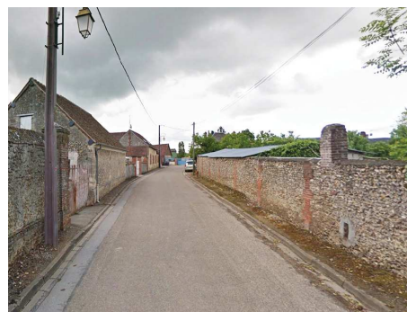
Murs anciens en pierres et briques.
