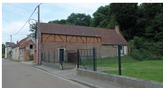
Construction ancienne pignon à l'alignement de la voie en pans de bois, brique et bois
