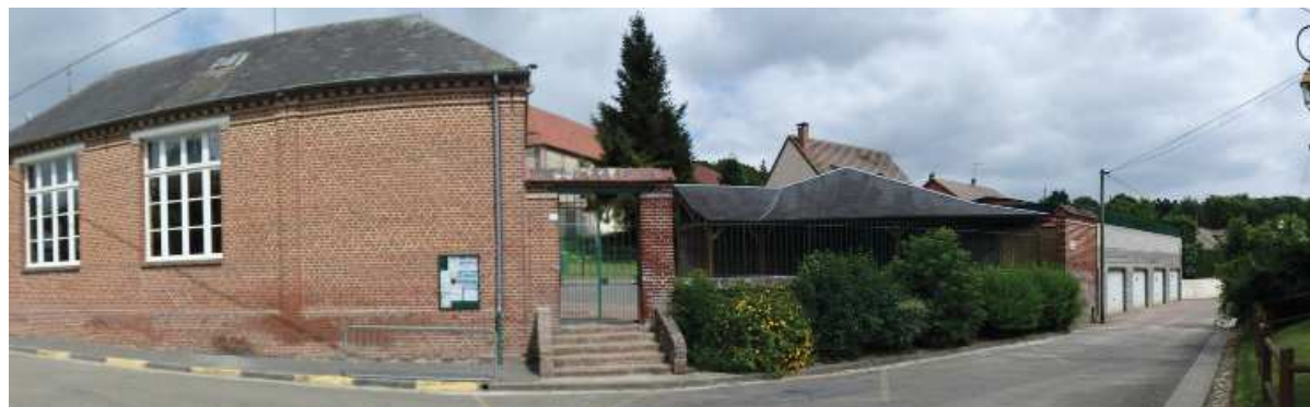
Ecole à proximité de la Mairie comportant une cour traversante entre la rue de la Mairie et la place publique aménagée sous forme de mail végétal ponctué d'équipements sportifs.
