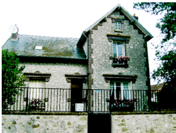
Construction type maison bourgeoise en pierres.
