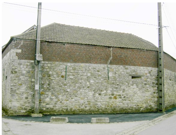
Façade en moellons surmontés de briques rouges.
