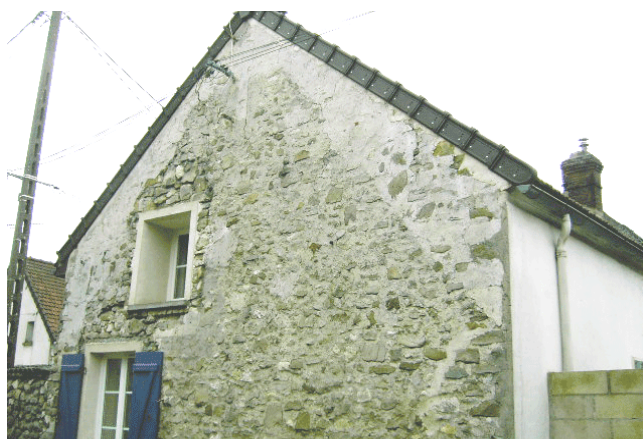
Pignon en moellons d'une construction traditionnelle.
