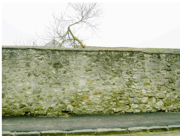
Mur de clôture en moellons donnant sur la rue.
