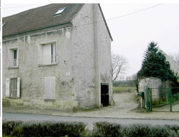
Construction en moellons et enduits ton pierre.
