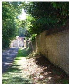
Les murs structurants...
