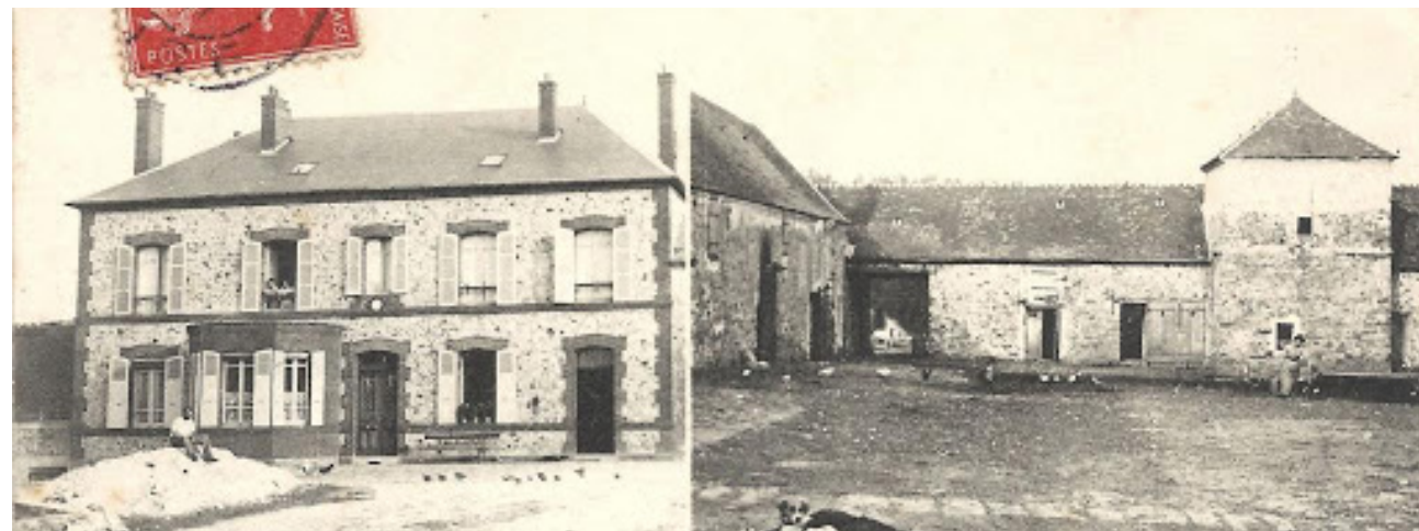
Le patrimoine bâti du corps de ferme du Bois Milon
