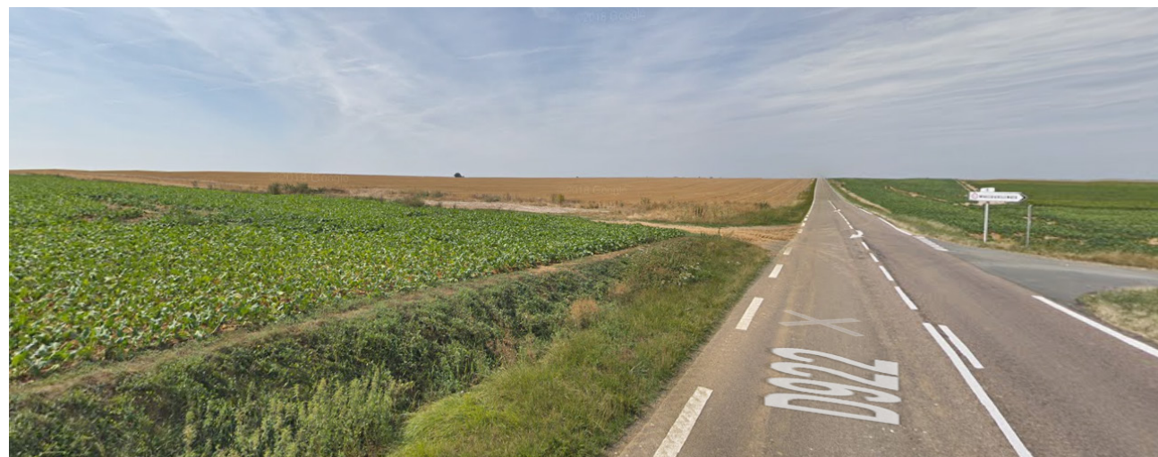
Carrefour entre la RD922 et la route du Bois Milon
