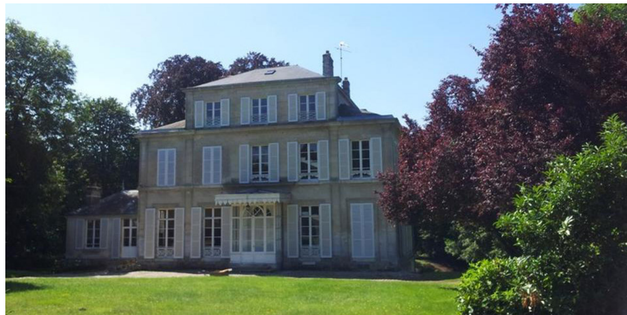
Le patrimoine bâti de la ferme de Macquelines : le château
