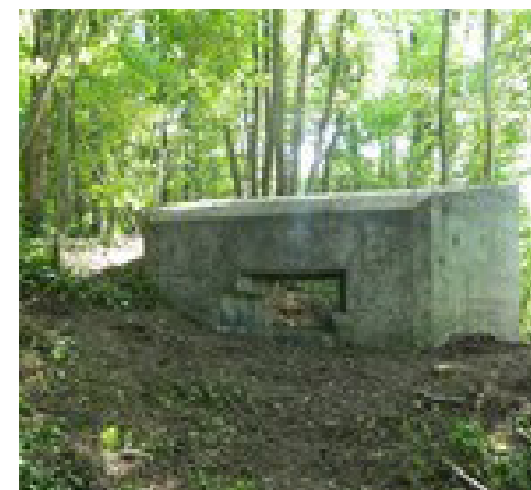
Blockhaus de la ligne Chavineau à Macquelines
