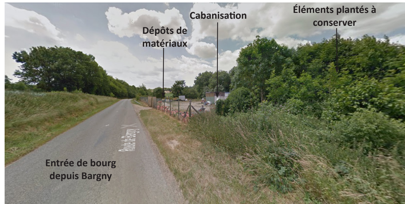
Activité de stockage de matériaux du BTP depuis l'entrée de bourg nord-est (RD51 route de Bargny)
