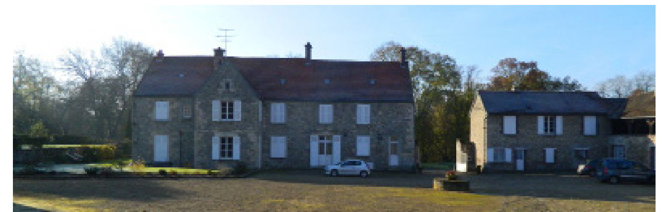
Le patrimoine bâti de la ferme de Macquelines : les dépendances
