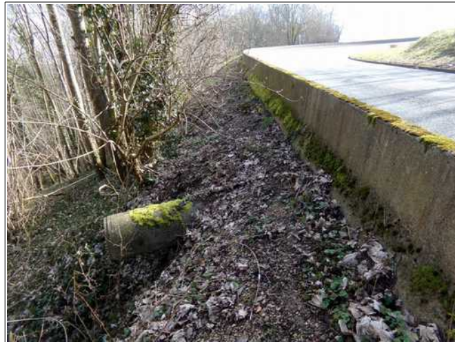
Figure III.4: buse à l'aval du parapet de la RD332.
