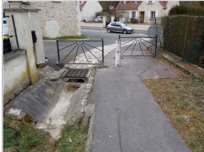
Figure III.8: entrée du busage du fossé et franchissement de la rue des Bourbottes. On notera l'étroite ouverture de la buse.
