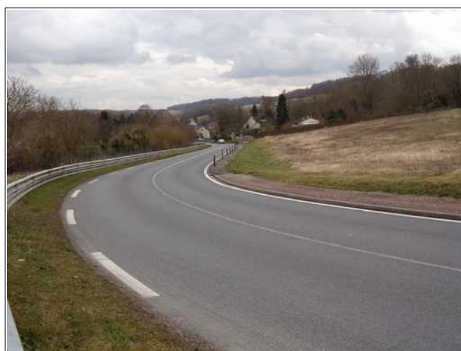
Figure III.15: RD332 à l'entrée du village. On notera son profil qui peut renvoyer les écoulements à l'aval de la chaussée.
