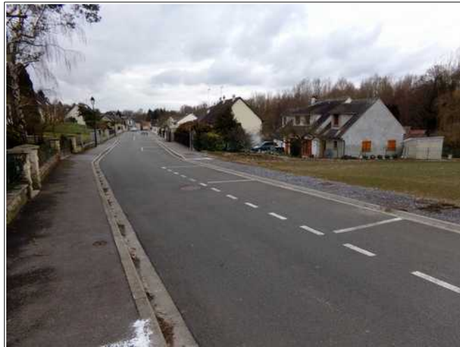
Figure III.11: les écoulements peuvent atteindre la rue des Bourbottes et se diffuser en direction des propriétés situées à l'aval.
