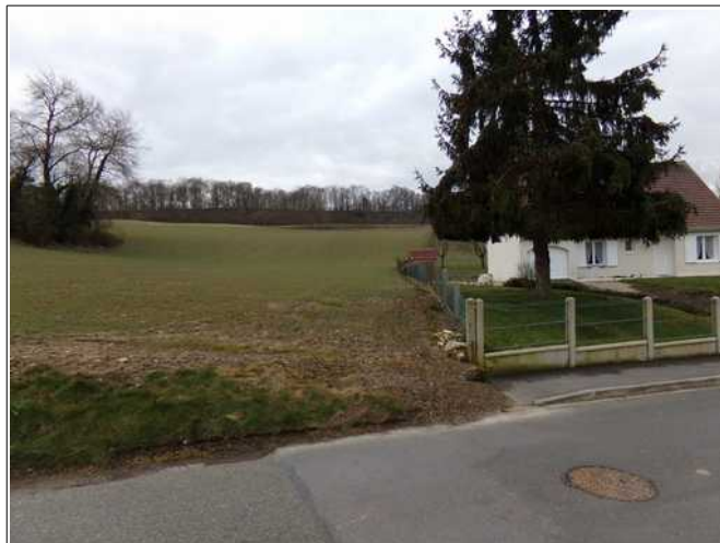
Figure III.10: les eaux du talweg longent préférentiellement la clôture de la propriété. Par contre, l'axe naturel du talweg traverse des propriétés, dont celle de la photo. Un cheminement préférentiel de 3 mètres de large doit être créé (voir ci-dessous).
