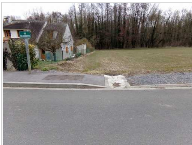
Figure III.12: aménagements actuels le long de la rue des Bourbottes pour détourner les écoulements. Des travaux complémentaires doivent être réalisés.
