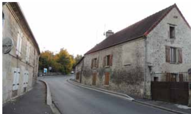
Sécurisation du virage Rue Nationale - Source: Cabinet Gossart
