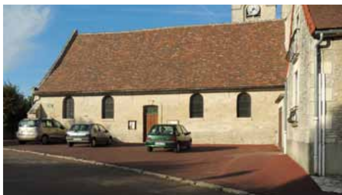
Stationnement, Placette de l'Eglise - Source: Cabinet Gossart
