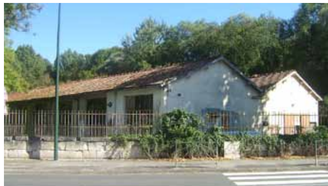
Bâti à usage d'activité - Source: Cabinet Gossart
