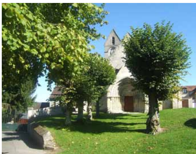
Espace public devant l'Eglise- Source: Cabinet Gossart
