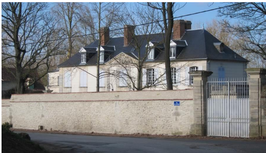
1 -Château de Berthecourt
