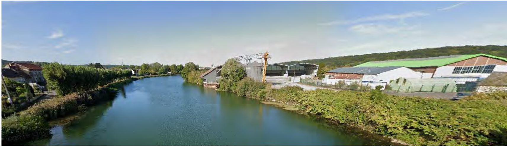
L'Aisne au niveau de la RD335
