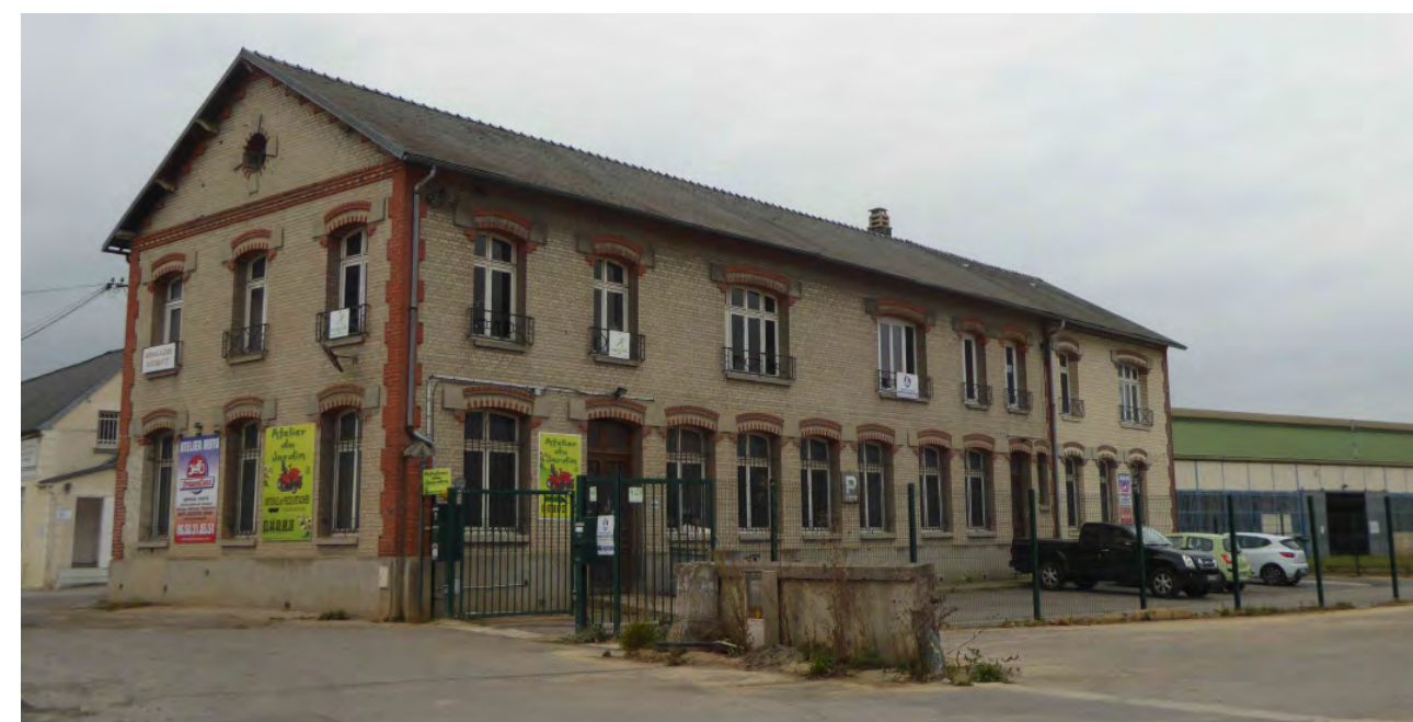
Bâtiment d'usine ancien en briques silico-calcaire avec modénature en brique rouge
