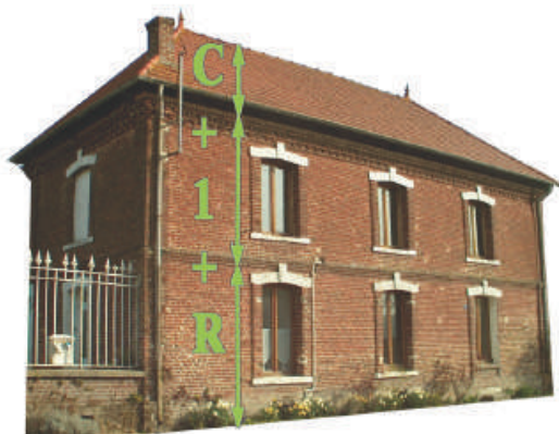
Hauteur d'une maison du village
