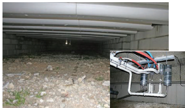
Illustration d'un vide sanitaire avec ses équipements
