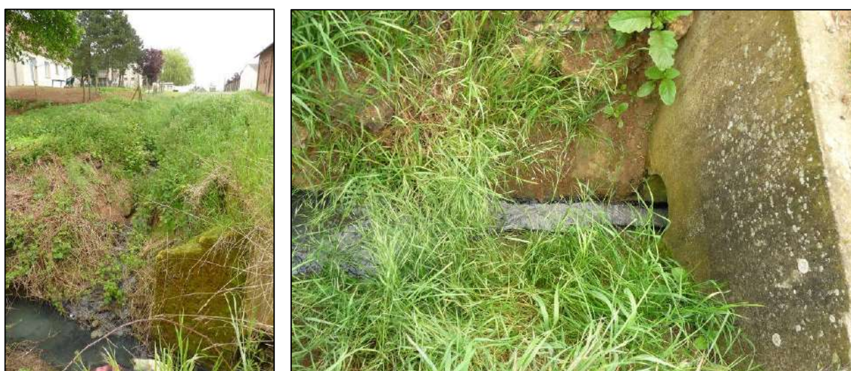
Figure 93: Exutoire d'eaux usées mal ou non traitées se jetant en aval dans la Verse
