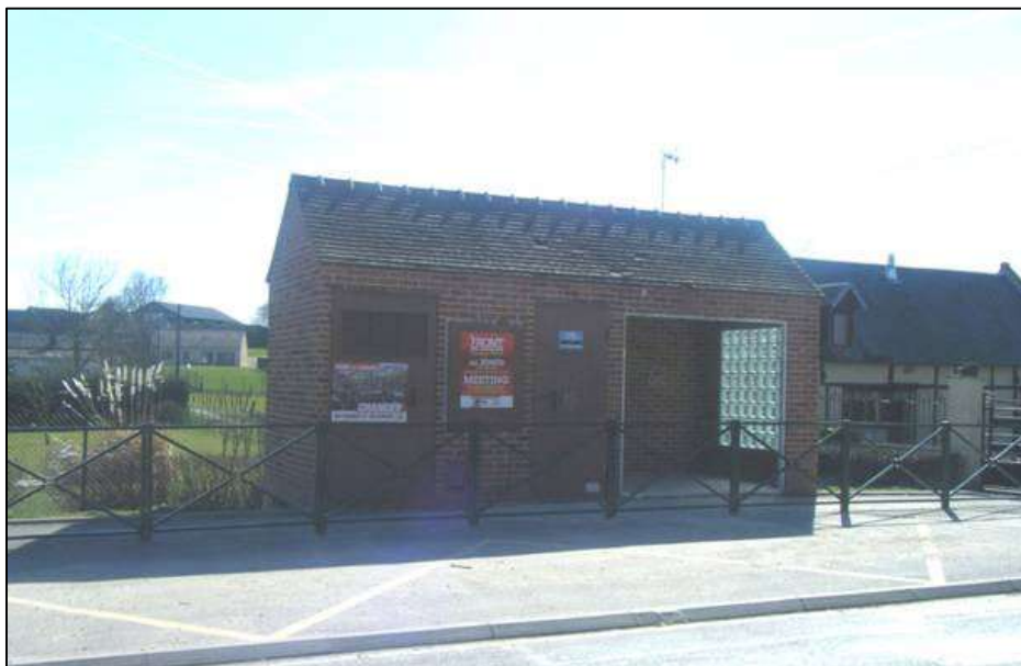
Figure 151: Abris bus situé au Nord le long de la RD91
