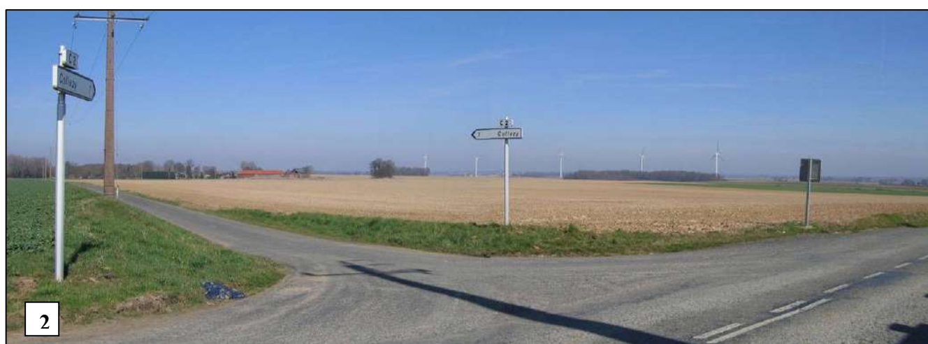
Figure 98: Vue depuis le carrefour pour accéder à Collezy depuis la RD91
