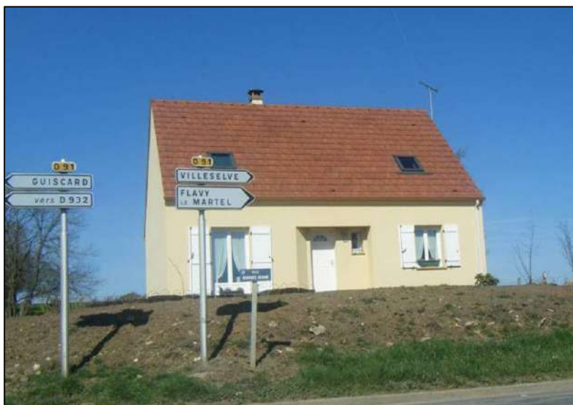
Figure 132: Construction récente (sortie nord de BERLANCOURT)
