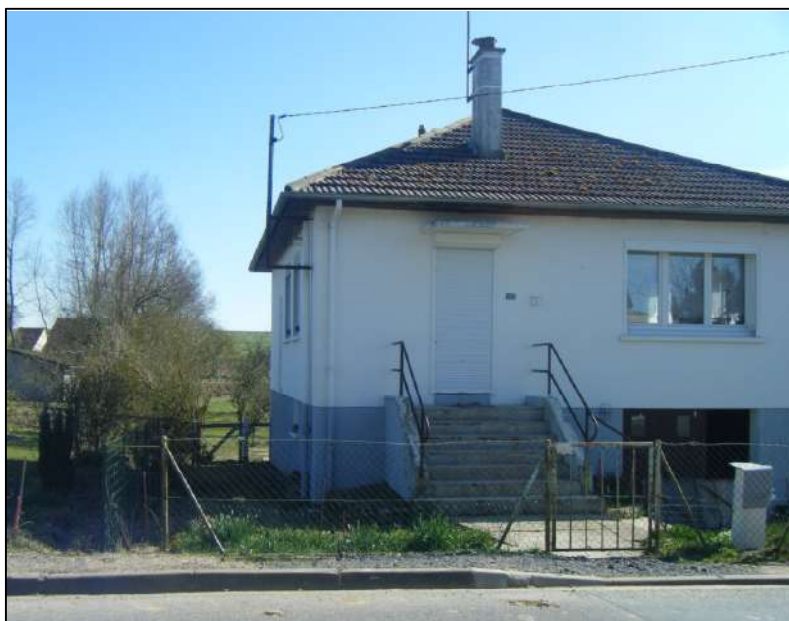
Figure 133: Construction intermédiaire (années 60) (entrée sud de BERLANCOURT, le long de la RD91)
